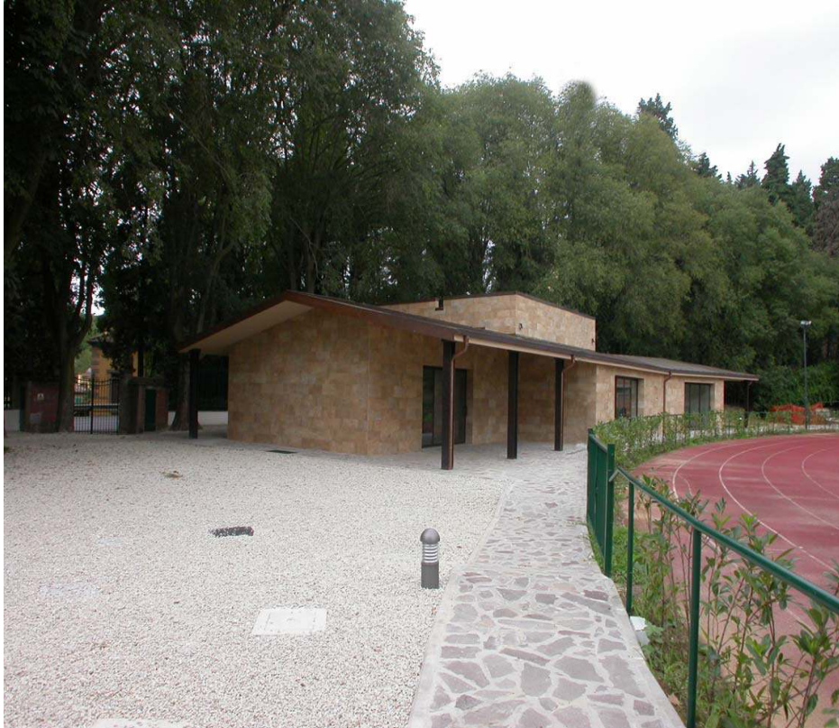
Complesso ASSI Giglio Rosso – Club House
